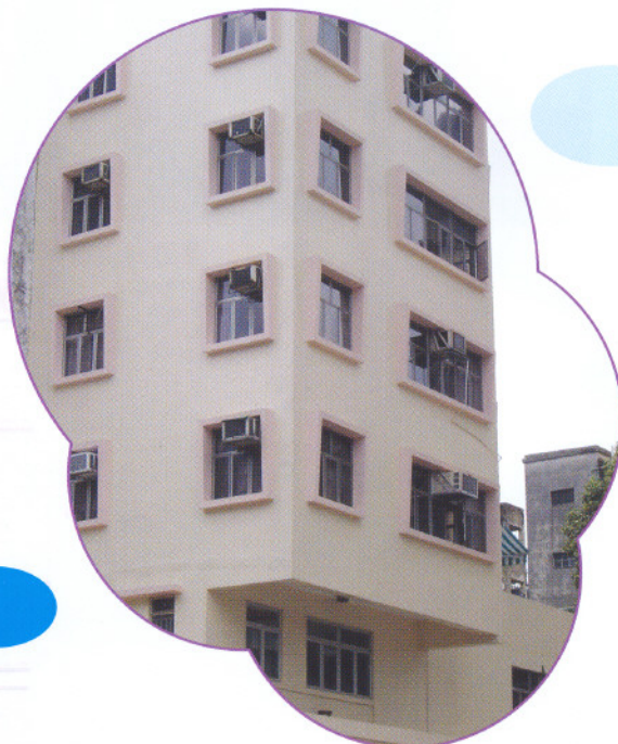
適當地使用油漆來粉飾外牆，可為舊樓提供美化作用
