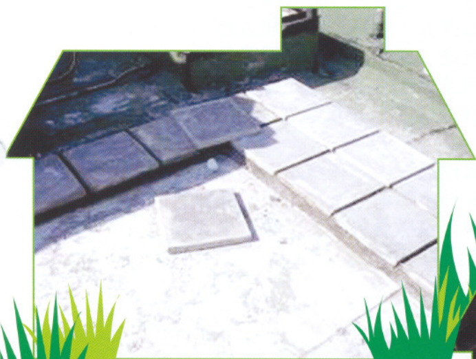
部份防水物料需加上飾面(如: 隔熱磚)保護
