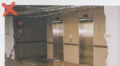
拆去消防員升降機門廊
