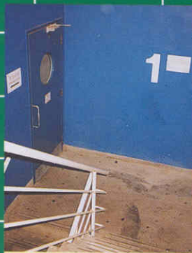
樓梯及消防門
