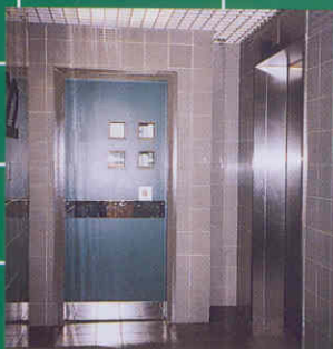
消防員升降機門廊
